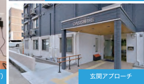
非常・災害時用自家発電装置
